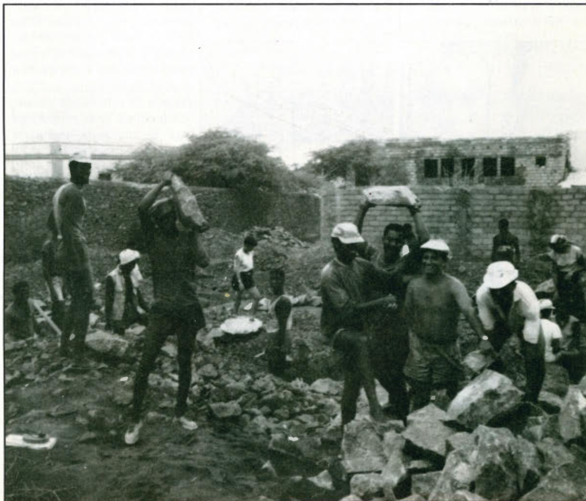
Le chantier commence : les fondations pour une auberge de jeunesse
