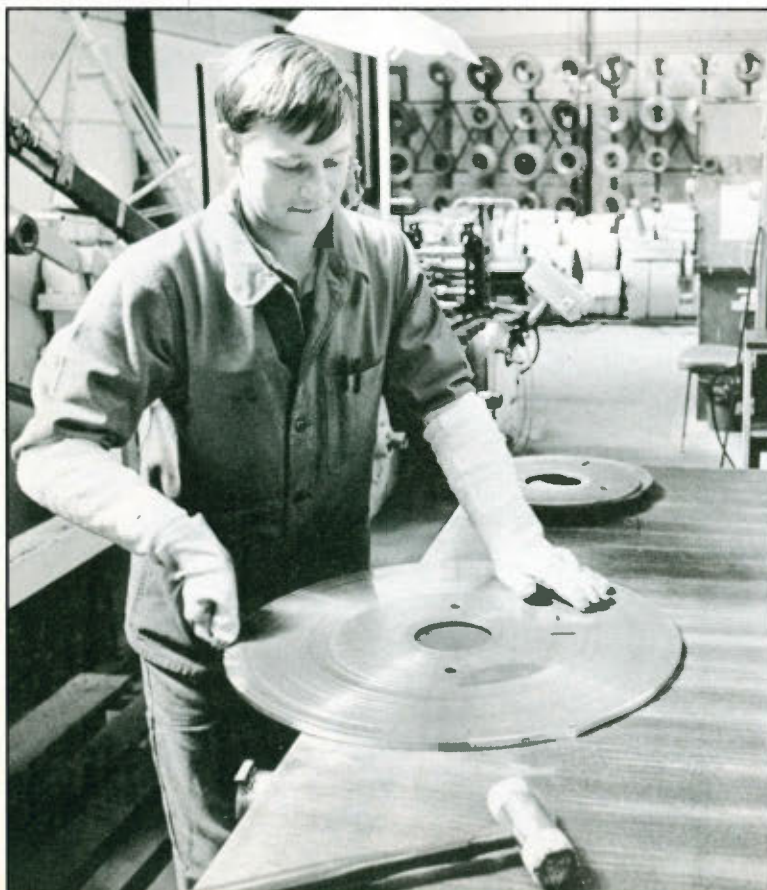
Dernières finitions sur une bobine de CuSN3 Zn9: un mélange d'alliage et de savoir faire
