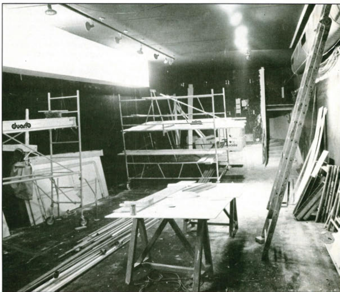
Si c'est un chantier, il préfigure l'inauguration, mi-décembre, d'une salle de cinéma totalement rénover.
